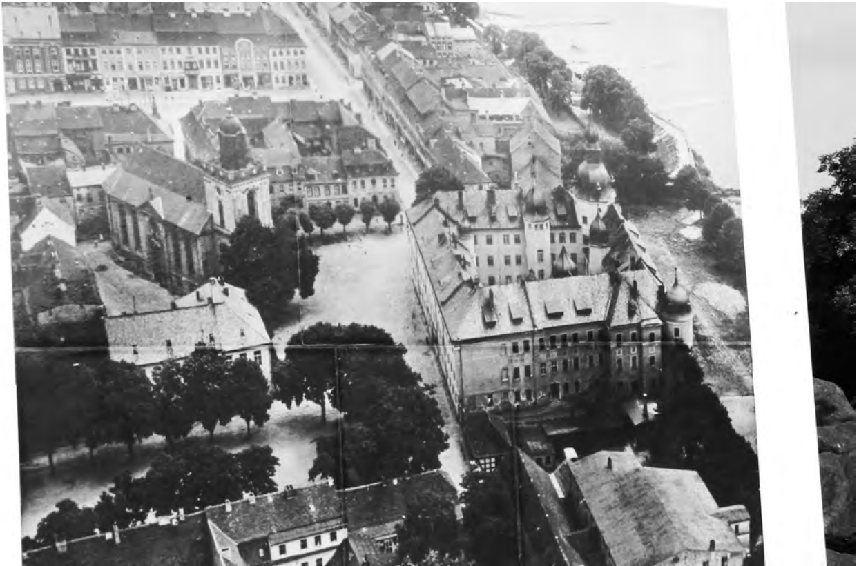
Blick auf die Altstadt vor der Zerstörung: Links oberhalb der Mitte die Marienkirche, rechts das Schloss.
